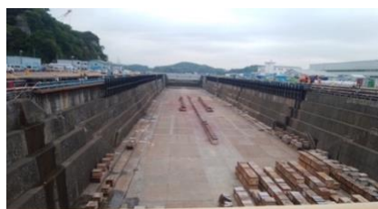
（昭和15年竣工、空母信濃を建造した6号ドライドック）
